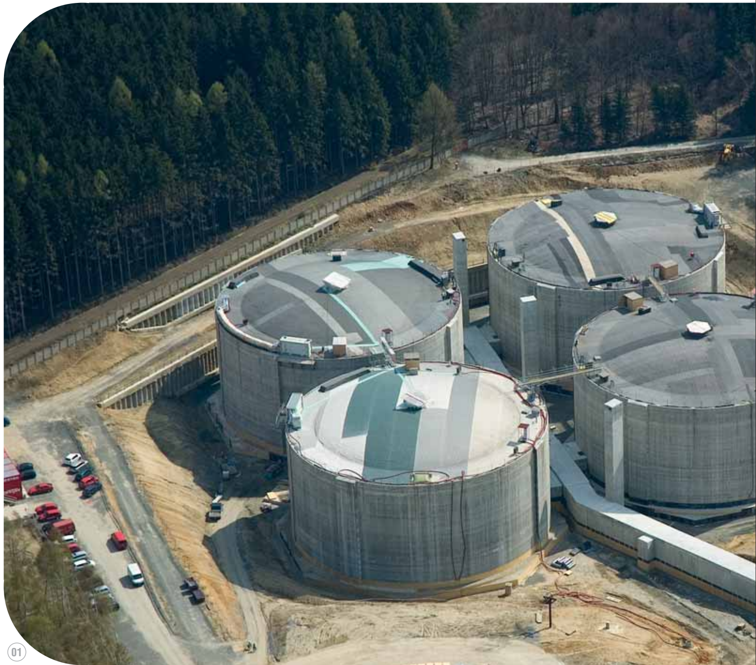
01 Podzemní nádrže PHM Čepro, Loukov, před zasypáním zeminou
